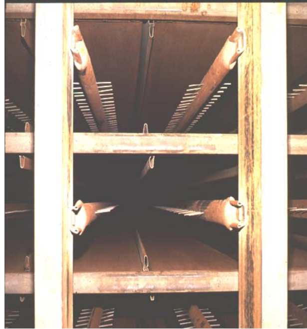
Montaža emisionih elektroda Tipa "Rigirode"
